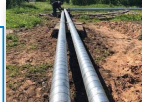
Капитальный ремонт системы водоснабжения (3,5 км) и замена насосных станций (2 ед.)
